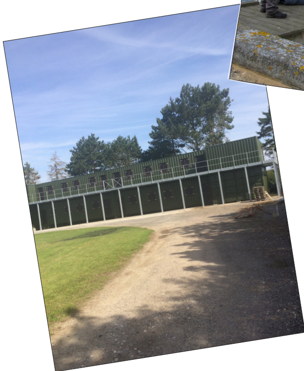
Lolland-Falster Brandvæsens nye øvelsesanlæg på Skibevej.
